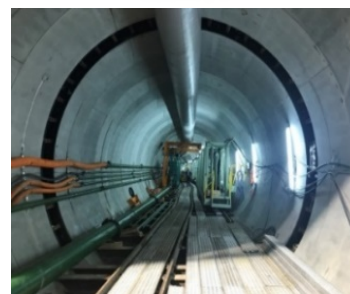
雨水管整備イメージ（中部2号幹線 内径5.00m）
