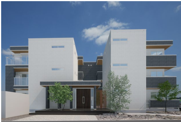
ルミナス空港東 大和ハウス工業株式会社 2024年6月竣工
