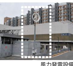
風力発電設備
