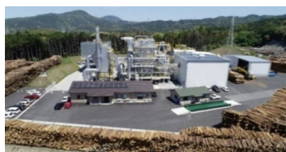
▲ふくおか木質バイオマス発電所
