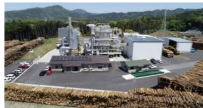
▲ふくおか木質バイオマス発電所
