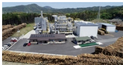
▲ふくおか木質バイオマス発電所
