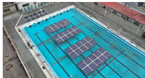
浮体式ペロブスカイト太陽電池
