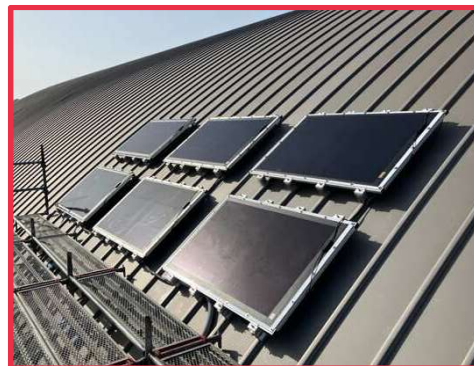
体育館屋根（アーチ型）
