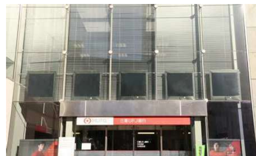
カーテンウォール 室内側
