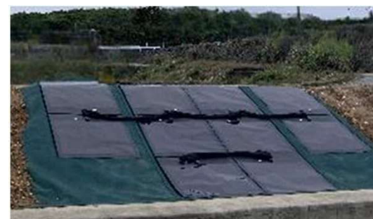
防草シートへの設置
