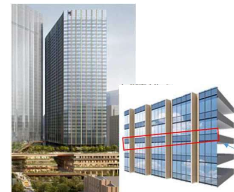
高層ビル スパンドレル部
