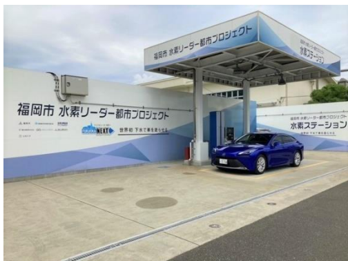
福岡市水素ステーション
