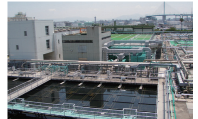
▲水処理センター
