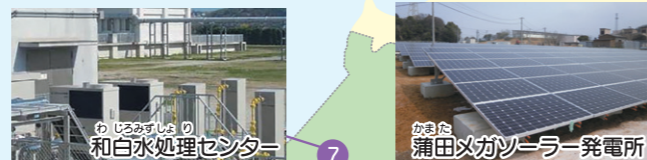
わじろあずしり 和白水処理センター 7 蒲田メガソーラー発電所
