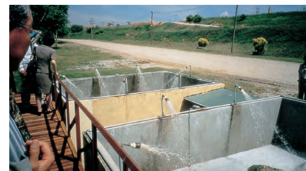
廃活性炭を使用した吸着処理
