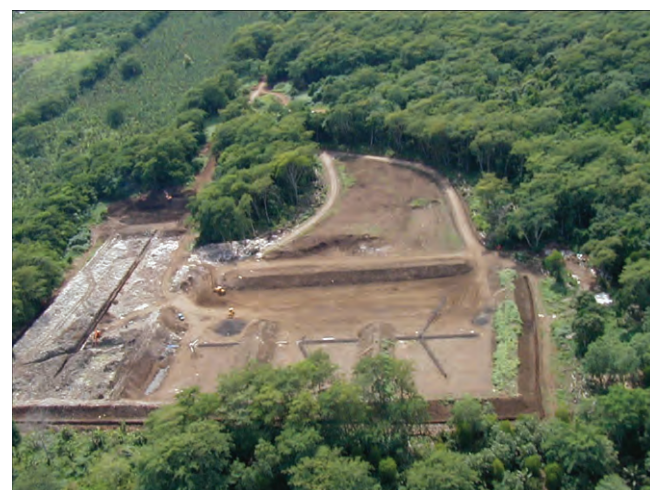
福岡方式に改善中の埋立場(2003年)
