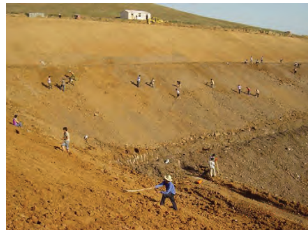
遮水シート施工前の法面の整形(2002年)
