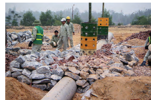
廃ドラム缶を使ったガス抜き管の施工(ベトナム国ハノイ市ナムソン埋立場)(2005年)
