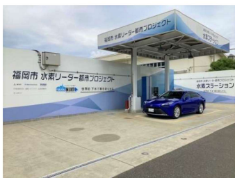
福岡市水素ステーション
