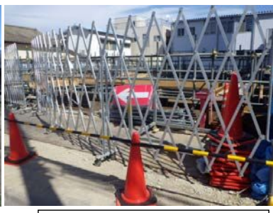
10階建ビルの基礎工事
