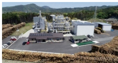
▲ふくおか木質バイオマス発電所
