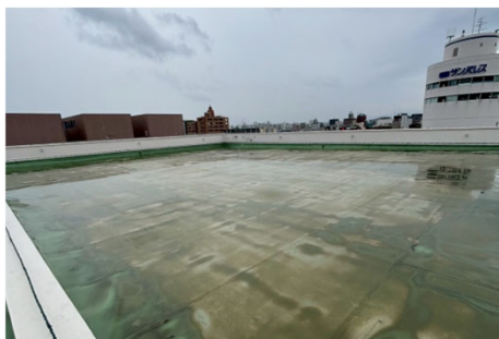
屋上防水の現況
