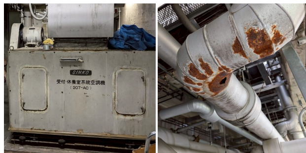
空調設備の現況
