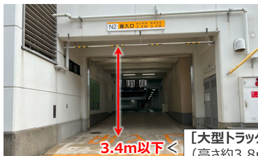
搬出入口の高さが不足
