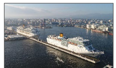
中央ふ頭西側岸壁の延伸（平成30年9月供用）
