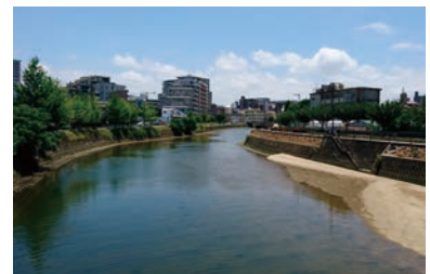
自然の豊かさを感じられる河川空間 (樋井川)
