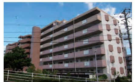
煉瓦をイメージした塗装とタイル張りの例 例) 老司・舞鶴
