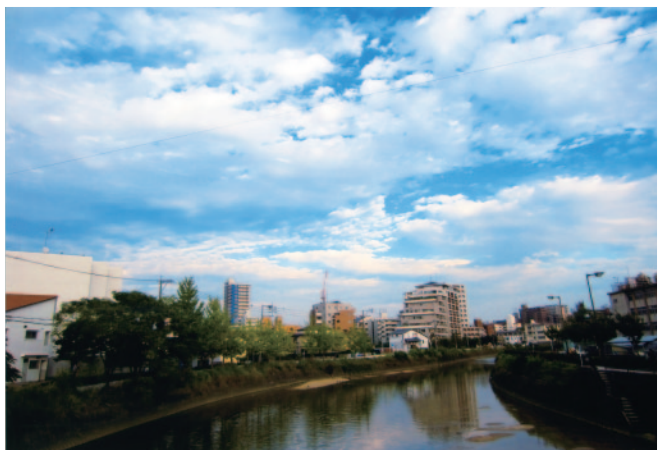
PM 04:52 〈撮影場所〉塩屋橋 〈撮影時期〉平成23年10月
