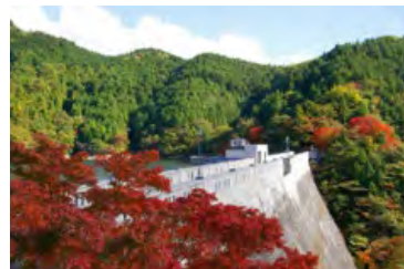
水の安定供給（曲渕ダム）
