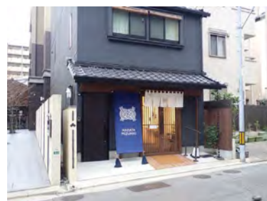
民間建築物の修景助成 （上呉服町）
