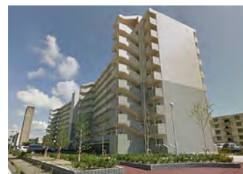
市営住宅の建替え (城浜住宅)
