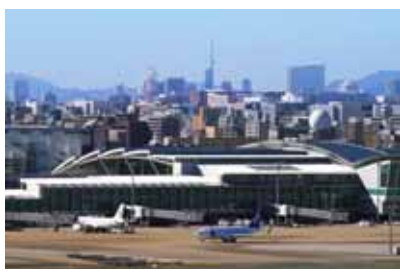
▲ 福岡空港国際線ターミナル
