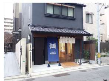
民間建築物の修景助成 （上呉服町）
