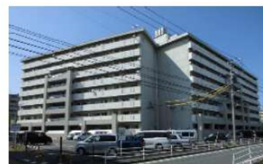
市営住宅の耐震化 (福浜住宅)
