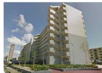
市営住宅の建替え (城浜住宅)
