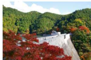
水の安定供給（曲渕ダム）
