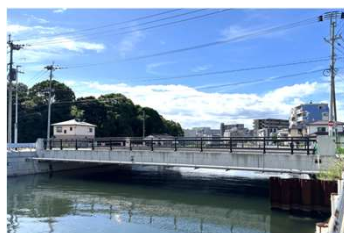
橋梁の耐震化 (西区興徳寺橋)
