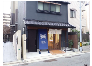
民間建築物の修景助成(上呉服町)
