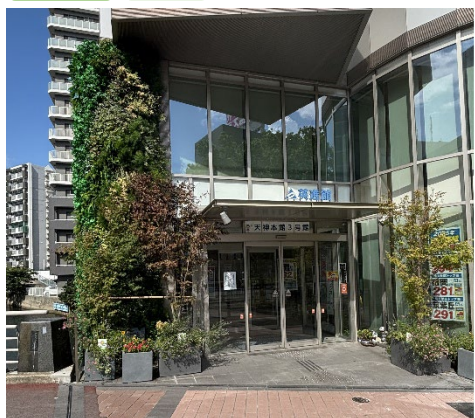
1F 屋外 壁面
