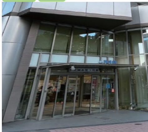
1F 屋外 壁面
