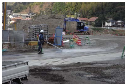
＜工事施工ヤードへの散水＞
