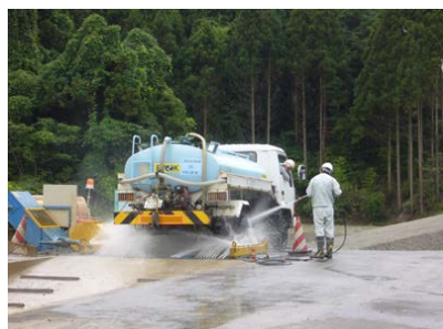
<工事用車両のタイヤ洗浄>
