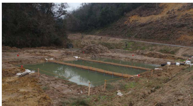
＜仮設沈砂池の設置＞
