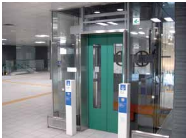
(エレベーターの設置)
