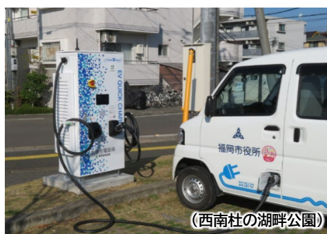
充電設備の設置 (西南社の湖畔公園)
