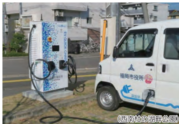
(西南社の湖畔公園) 充電設備の設置
