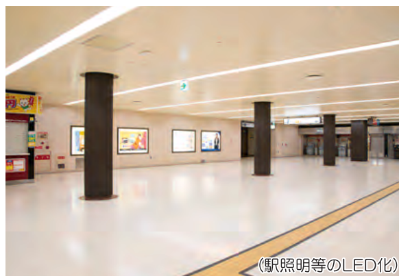
(駅照明等のLED化) 地下鉄駅の省エネルギー化
