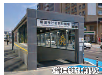
駐輪場の整備
