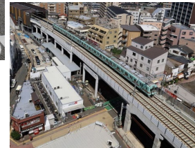
◇西鉄天神大牟田線 連続立体交差事業
