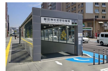
駐輪場の整備
