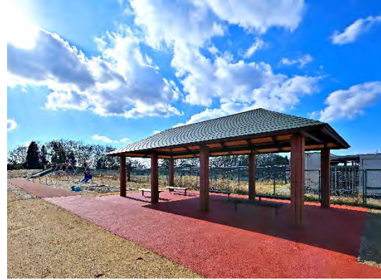
車椅子の走行性やアプローチを考慮した休憩所。
