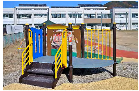
車椅子からの乗り移りデッキを設け、車椅子利用者も遊びやすい配慮がなされている。
