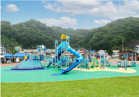
遊具エリアに施されたゴムチップ舗装。
