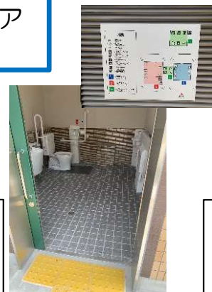
オストメイト設備や 大型ベッドなどを備えた バリアフリートイレ
