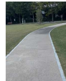
自然景観になじみ 車いすでも走りやすい 土固化舗装
