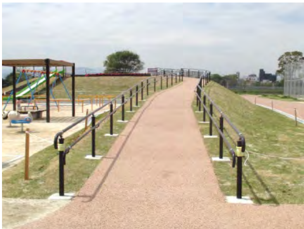
公園のバリアフリー（スロープや手すりの設置）
