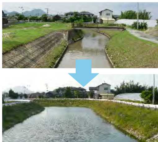
河川の改修（周船寺川の拡幅）
