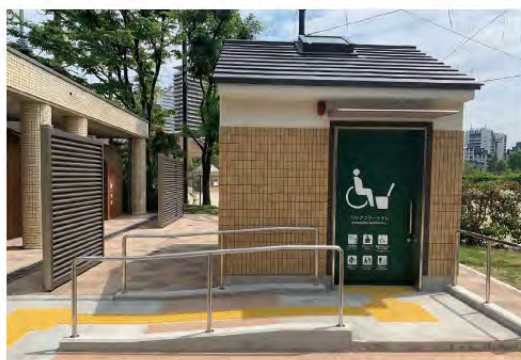
音声案内や介助用の大型ベッド、オストメイト施設などが設置されたバリアフリートイレ
