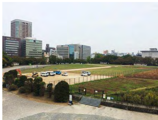
鴻臚館跡広場(工事中)
