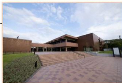
〈新設した大濠公園側からのアプローチ〉
