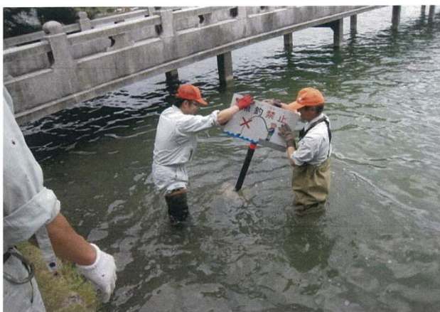
写真：注意看板の設置作業
