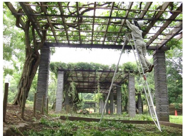
写真：フジ棚の剪定作業
