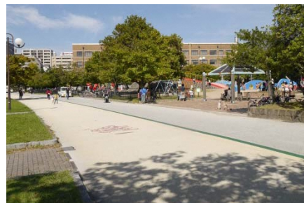
周回園路のゴムチップ舗装
