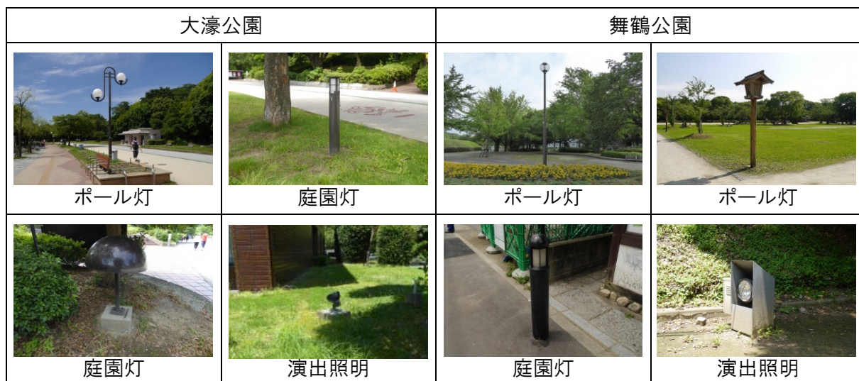
写真：両公園の照明施設
