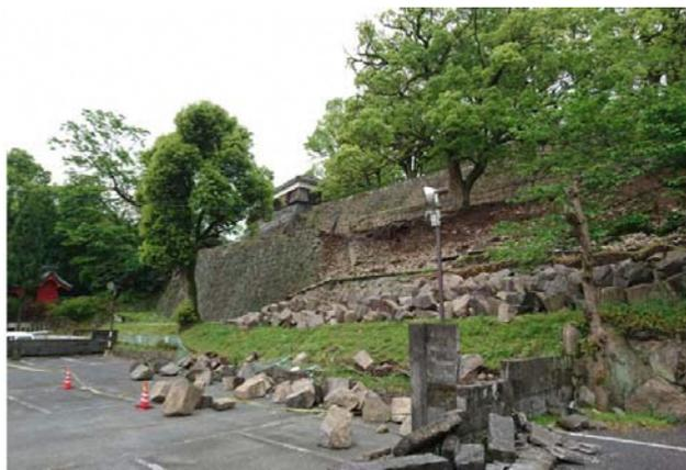
図：熊本地震による熊本城の石垣の崩壊状況
