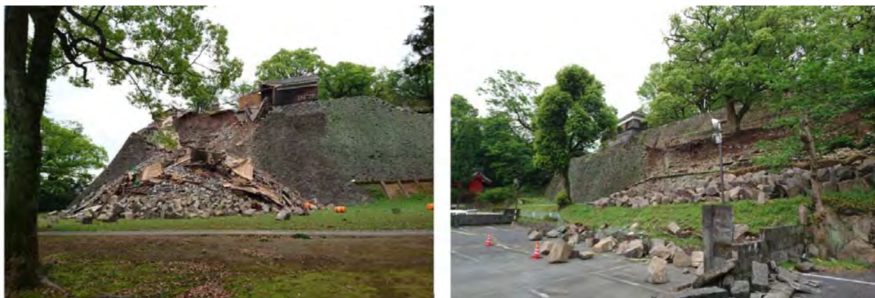
図：熊本地震による熊本城の石垣の崩壊状況
