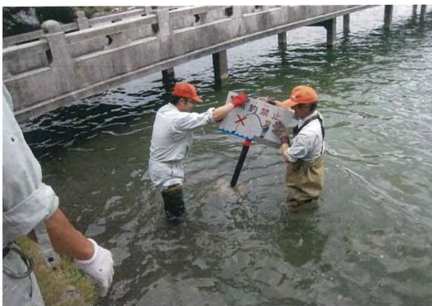
写真：注意看板の設置作業
