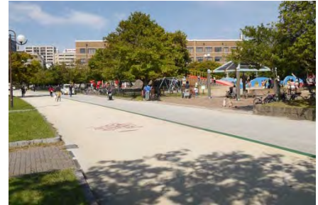
周回園路のゴムチップ舗装
