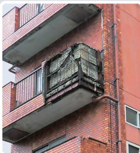
バルコニーの外壁が剥離・落下している様子
