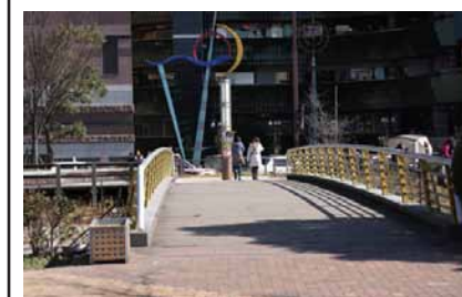
⑨夢回廊橋
