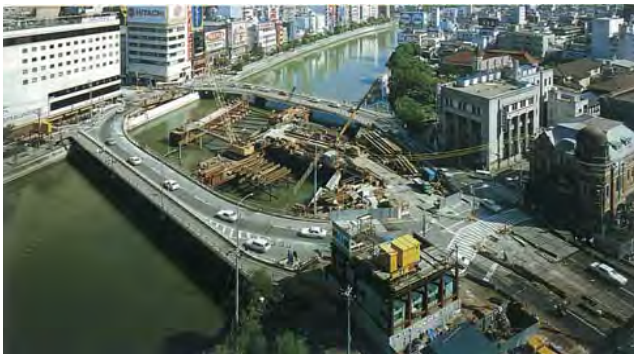
⑤地下鉄工事と西大橋の整備
