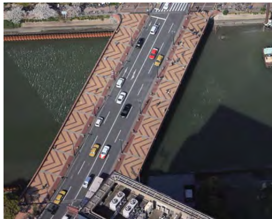
⑤整備後の西大橋
