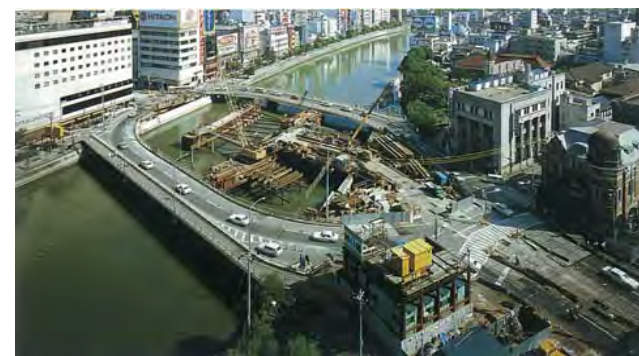
⑤地下鉄工事と西大橋の整備
