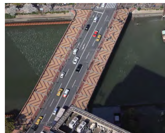
⑤整備後の西大橋
