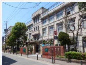
旧大名小学校南校舎 外観
