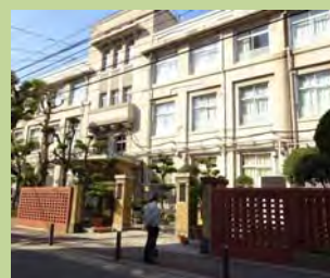
・旧大名小南校舎(昭和4年建築)
