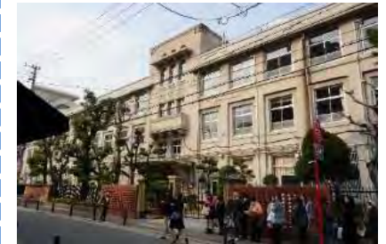
⑤S4建築の旧大名小学校南校舎
