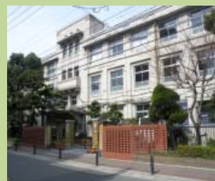
・旧大名小南校舎(昭和4年建築)
