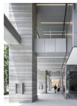
After：補強された既存躯体を活用
