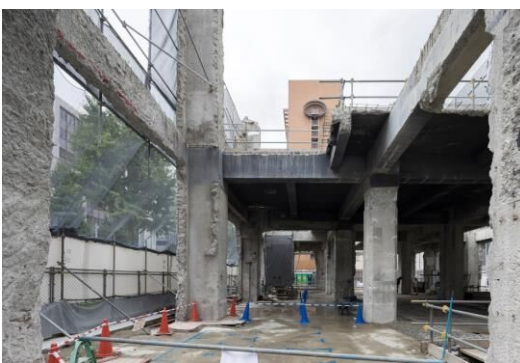
Before：活用する躯体を残し、従前建物を解体
