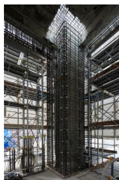
躯体を補強するため周囲に配筋
