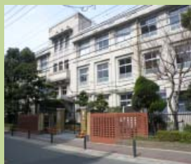
・旧大名小南校舎(昭和4年建築)
